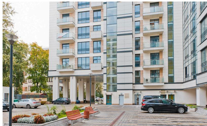
**Конструкция:** монолитно-железобетонный каркас; наружные, внутренние стены - кирпич.
